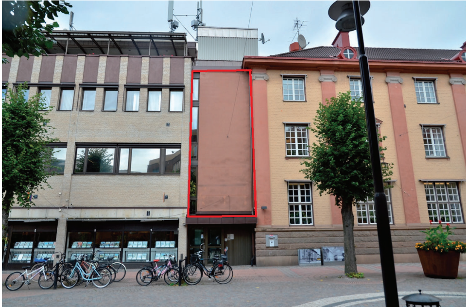
Det sammanlänkande trapphuset mellan nya- och gamla bankbyggnaden markerat i rött.
