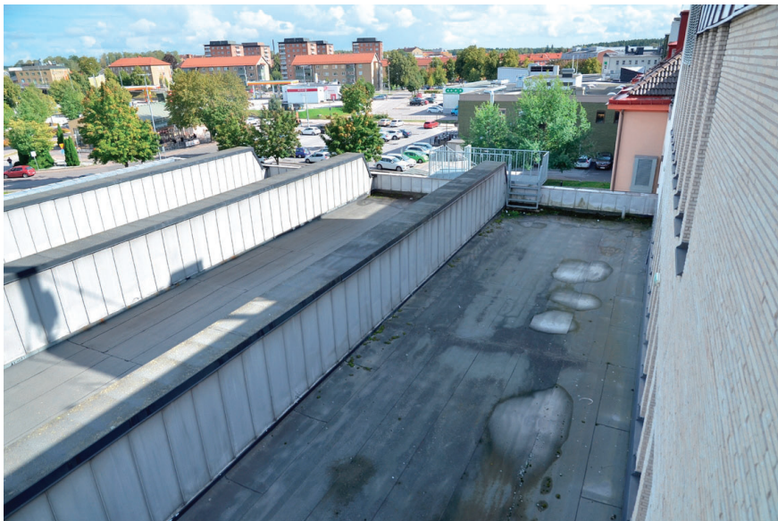
Bjälkarna på taket, bild från antikvariska konsekvensutredningen.
