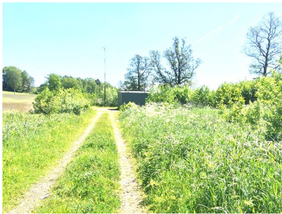
Grusväg vid Forssjön och pumpstation för reservvatten
