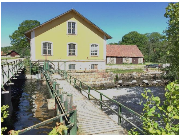
Gamla kraftverket från 1899
